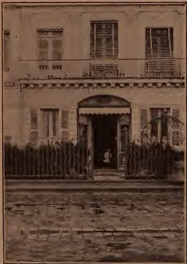
Vue extérieure de la Crèche
